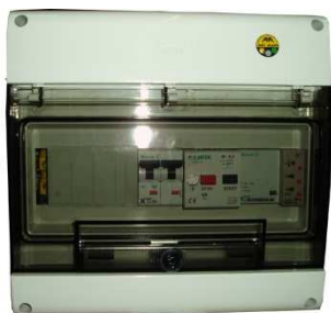
Cuadro de potencia
