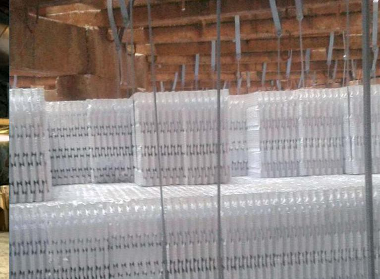
Un esempio di progettazione finalizzata alla fornitura. Questa torre iperbolica è stata ripotenziata con il prodotto FMV21 in PVC LT (bassa temperatura). Il team tecnico ha dimensionato la sezione di riempimento per fare in modo di avere una resa superiore rispetto a quella precedente.
